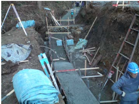
段変わり基礎コンクリート打設
