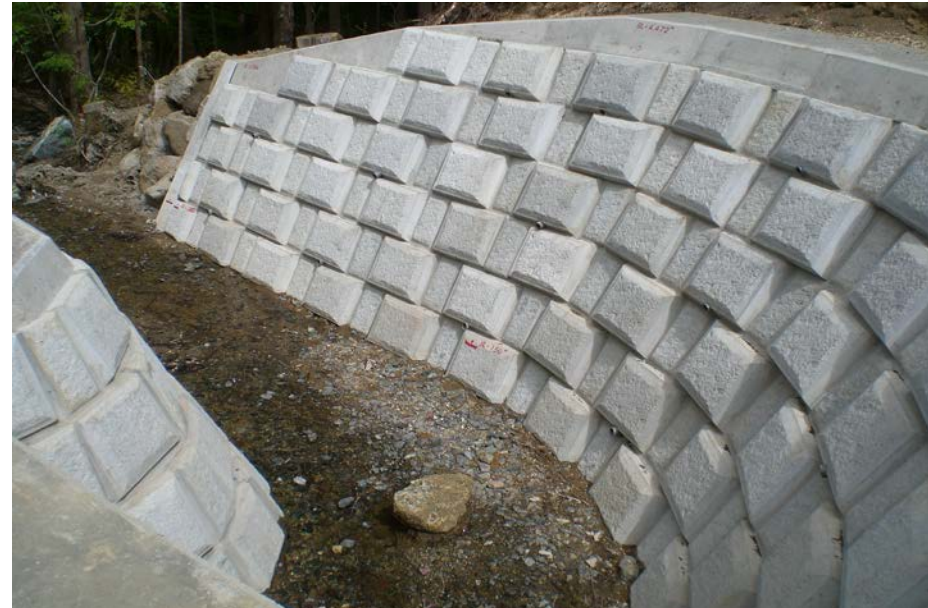
内カーブ R=3.0m 施工完了
