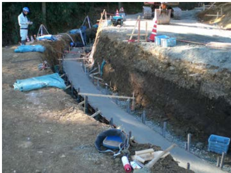
基礎コンクリート打設
