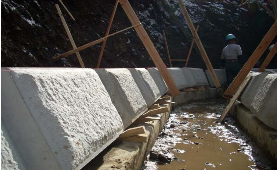
外カーブ R=1.0m 施工完了
