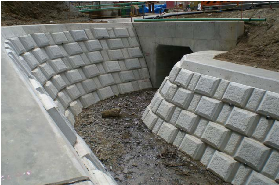
外カーブ R=1.0m 施工完了
