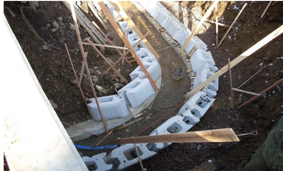
内カーブ R=3.0m 施工完了
