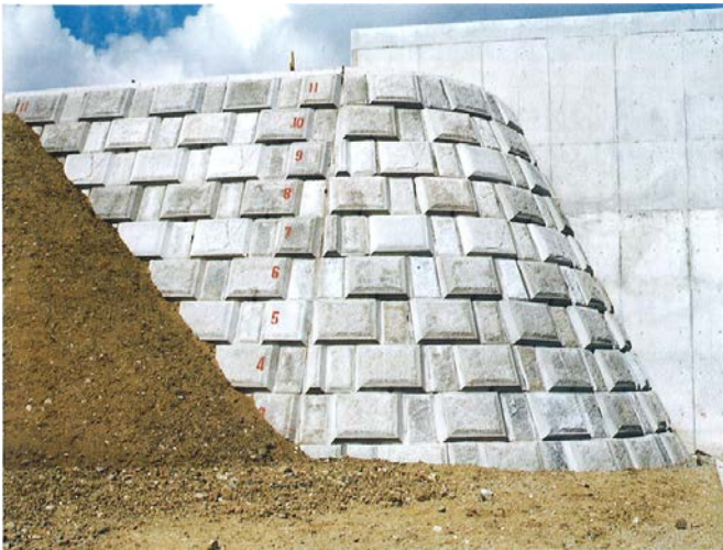
R = 1.6m 施工
