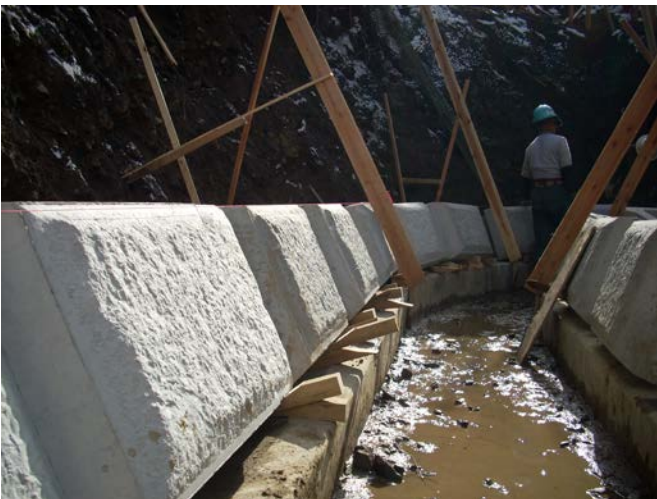
1段ブロックの敷設
